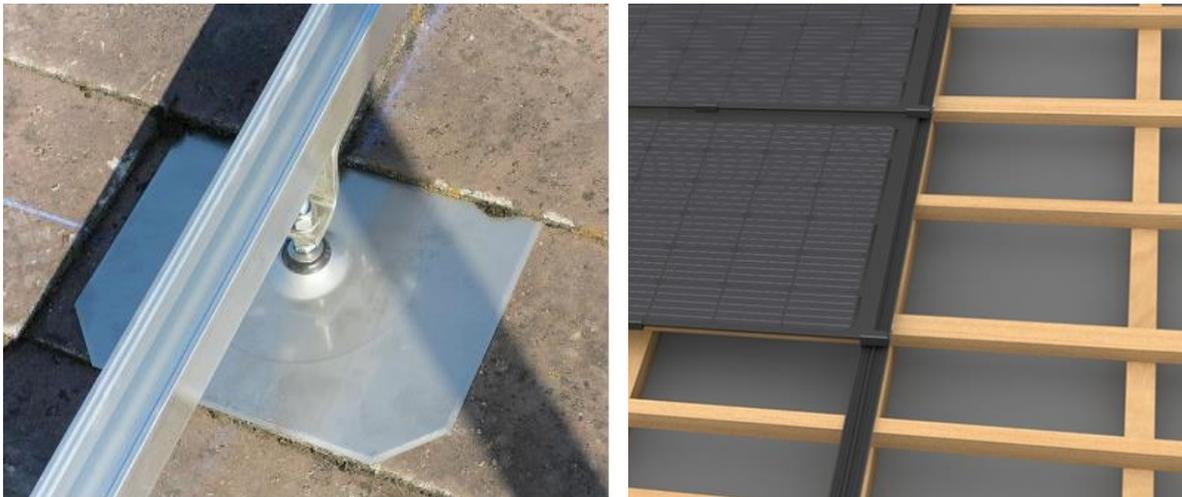
*Aufdachanlage Flacheternit mit Metallschindel (links) und Indachanlage (rechts).*
