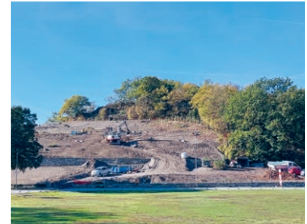
Dank dem guten Wetter konnten die Arbeiten im November 2022 weitergeführt werden.
