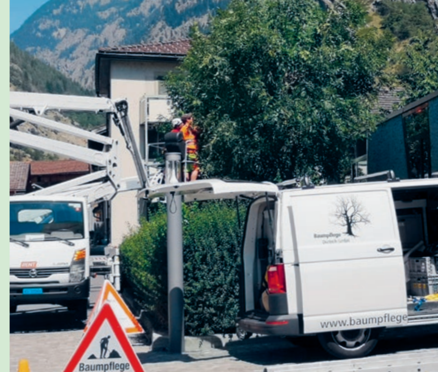
Signalisation sowie eine Hebebühne sind wichtig, um die Gefahren bei der Baumpflege zu minimieren.
