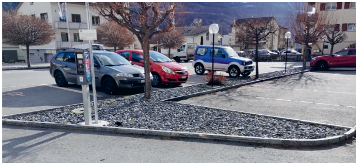
Vorher → Die Baumquartiere sind mit Schotter befüllt, welche sich im Sommer aufheizen.
