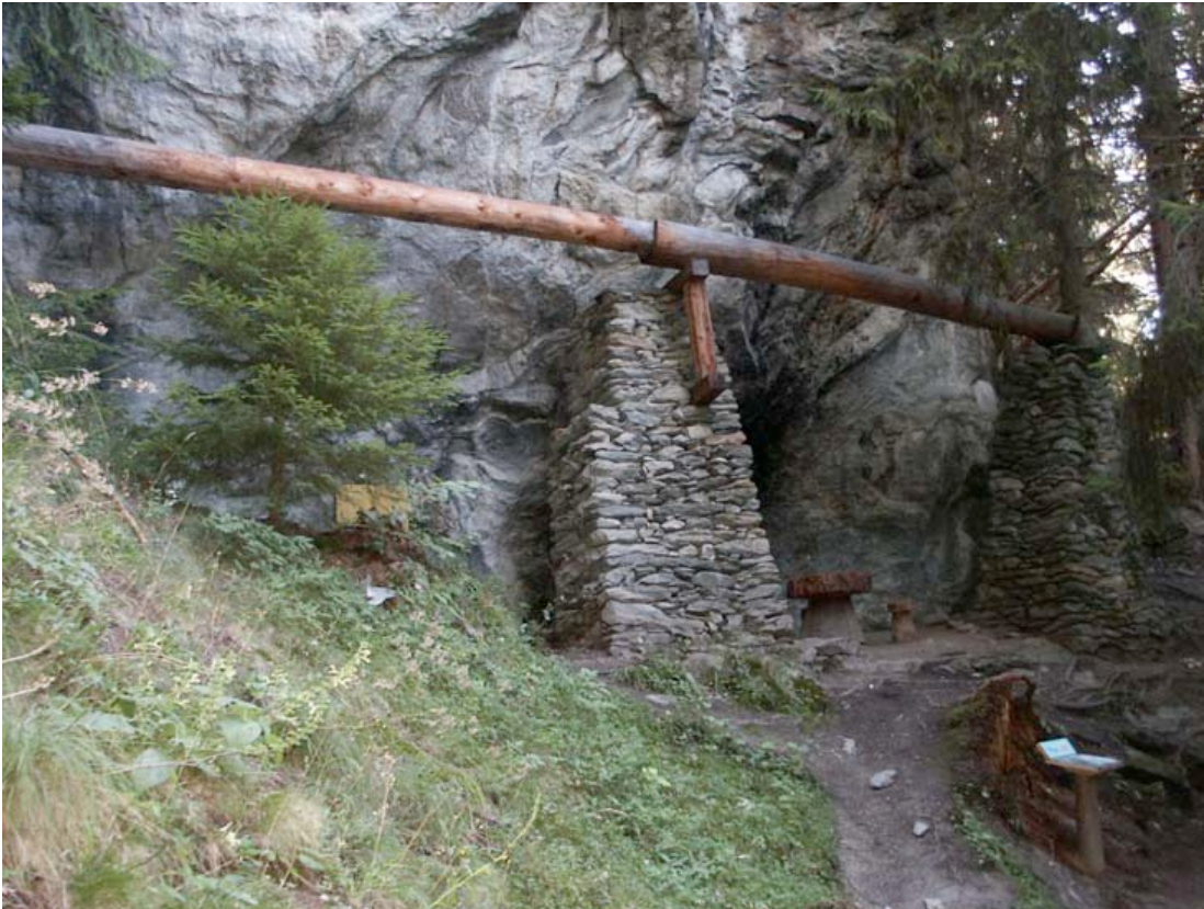
Abb. 3 Rekonstruktion einer hölzernen Hängewasserleite auf Steinpfeilern in Ried-Mörel. 46
